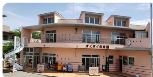
（修繕後の園舎）
