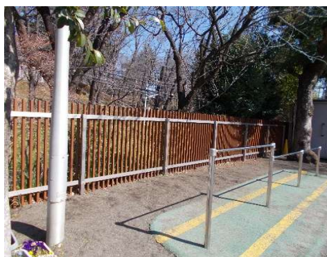
園庭周りの柵 修繕
